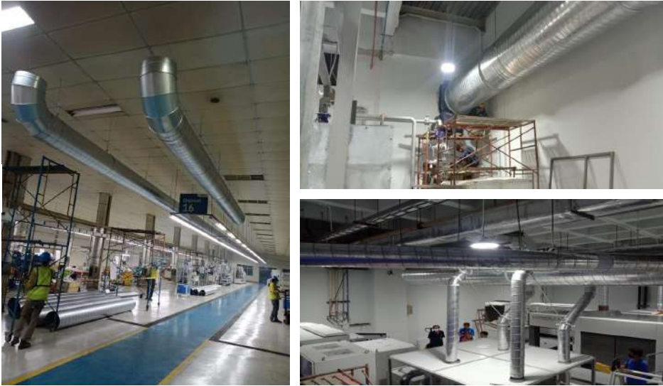
Project : Instalasi Ducting Pabrik Peruri - Kawasan Produksi
